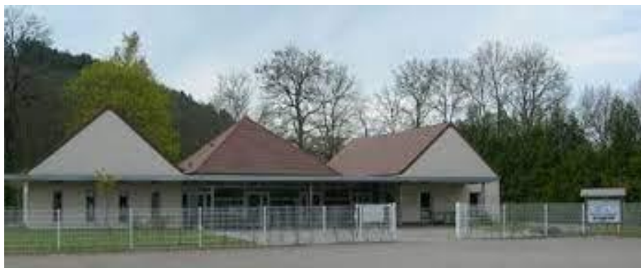
Figure 54. Centre de loisirs Les Filous Futés - Deux Rivières
